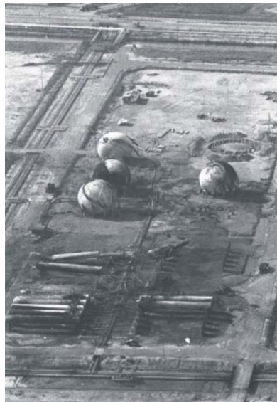
Figura 34: Parque de armazenamento após o incêndio. Fonte: http://inspecaoequipto.blogspot.com.br .
