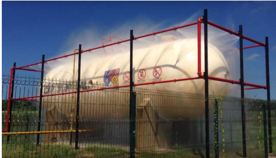
Figura 26: Sistema de nebulização de tanques GLP. Fonte: https://www.youtube.com/watch?v=vyE8KODiSV0 .
