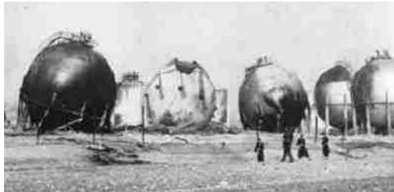
Figura 32: Esferas após o incêndio. Fonte: http://inspecaoequipto.blogspot.com.br .
