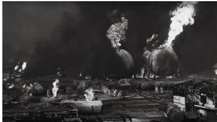
Figura 36: Parque de armazenamento em chamas. Fonte: http://inspecaoequipto.blogspot.com.br .
