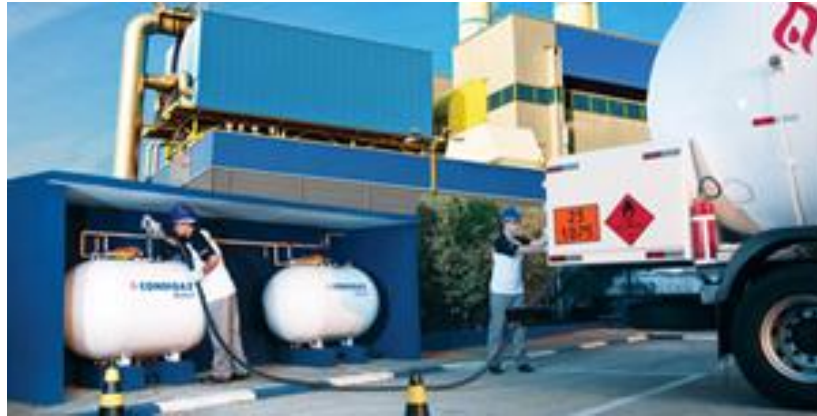
Figura 6: Sistema estacionário sendo abastecido. Fonte: http://propangas.com.br .
